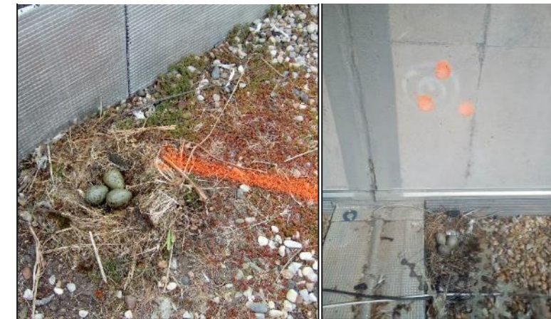
Figure 7 : Marquage à la bombe de peinture orange
